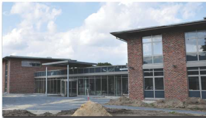
Der neue Gebäudekomplex kurz vor der Fertigstellung
